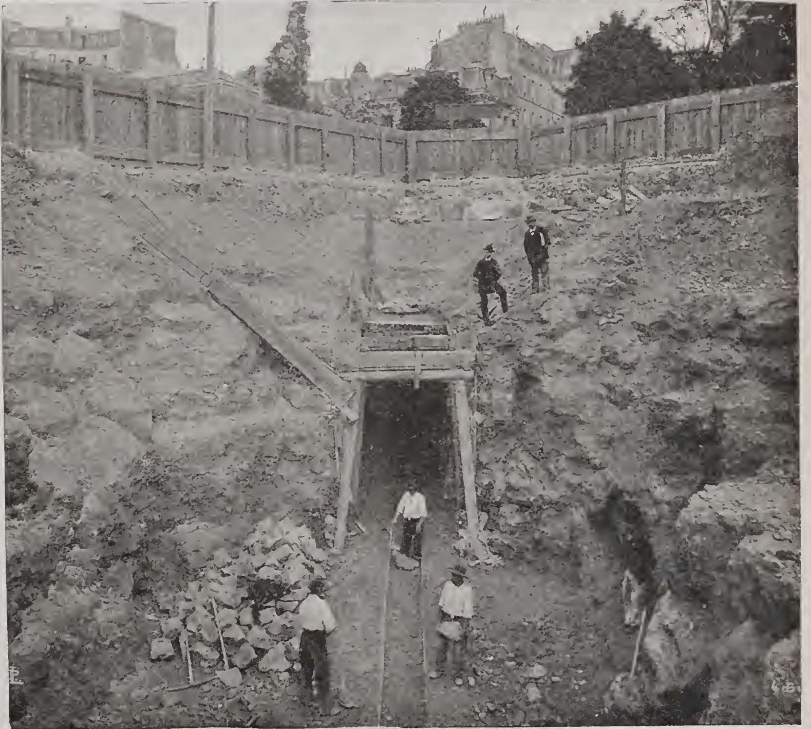
Station de Boulainvilliers. Galerie d'avancement, côté Courcelles
